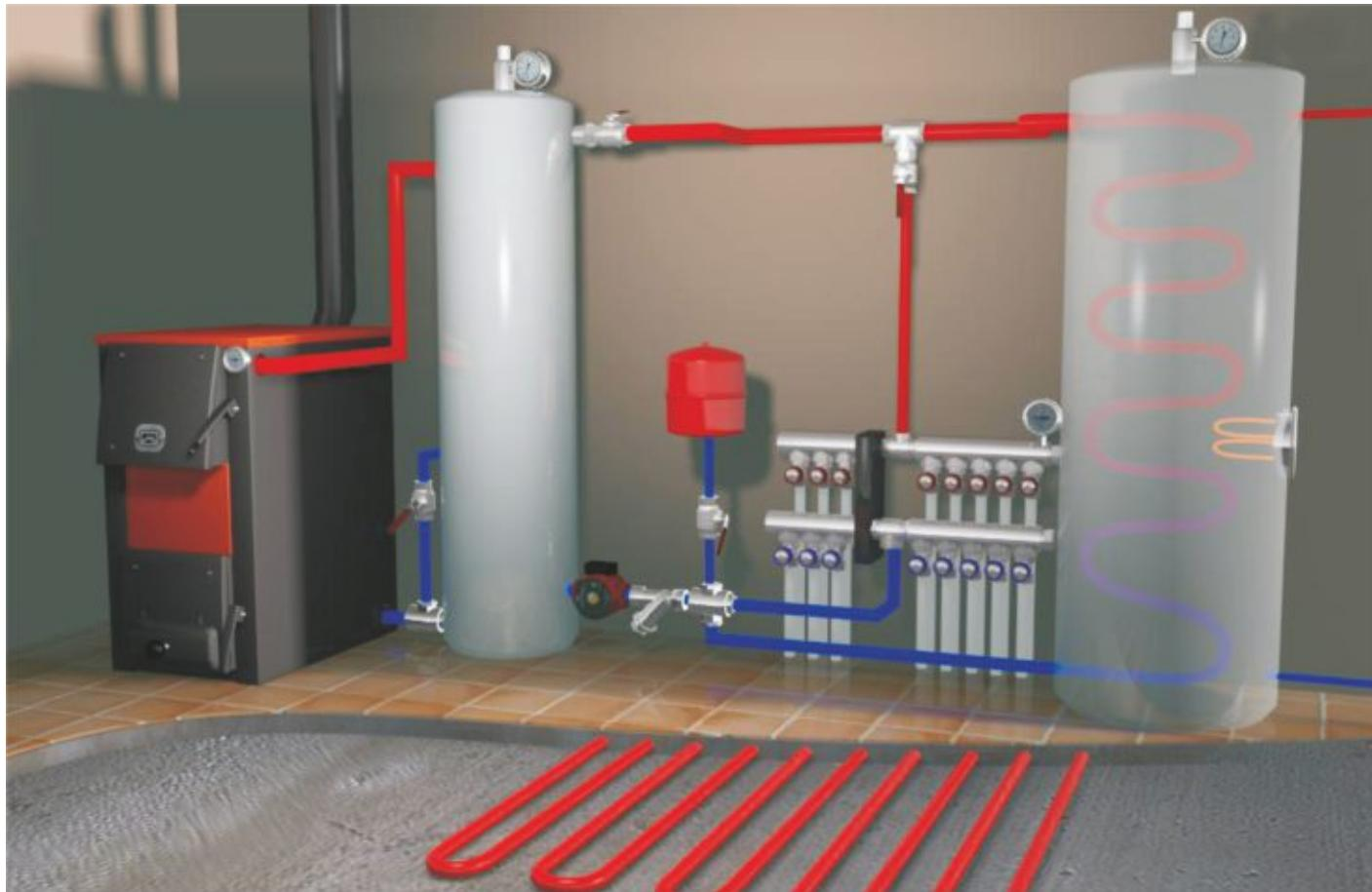
В системе установлены радиаторы отопления, теплые полы и бойлер косвенного нагрева для горячего водоснабжения. Для согласования системы отопления с котлом использован емкостной гидравлический разделитель.
